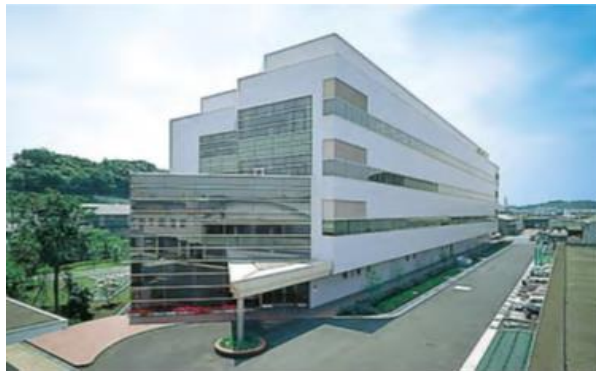
ポーラ化成工業 本社・横浜研究所
