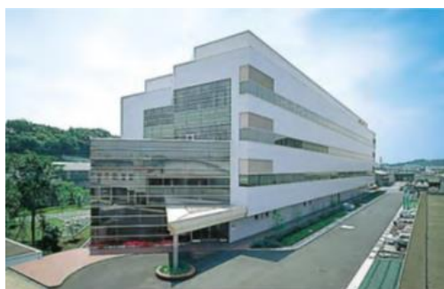
ポーラ化成工業 本社・横浜研究所
