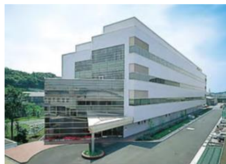
ポーラ化成工業 本社・横浜研究所
